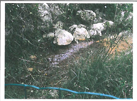
Sortie drain contrebas talus Ouest
